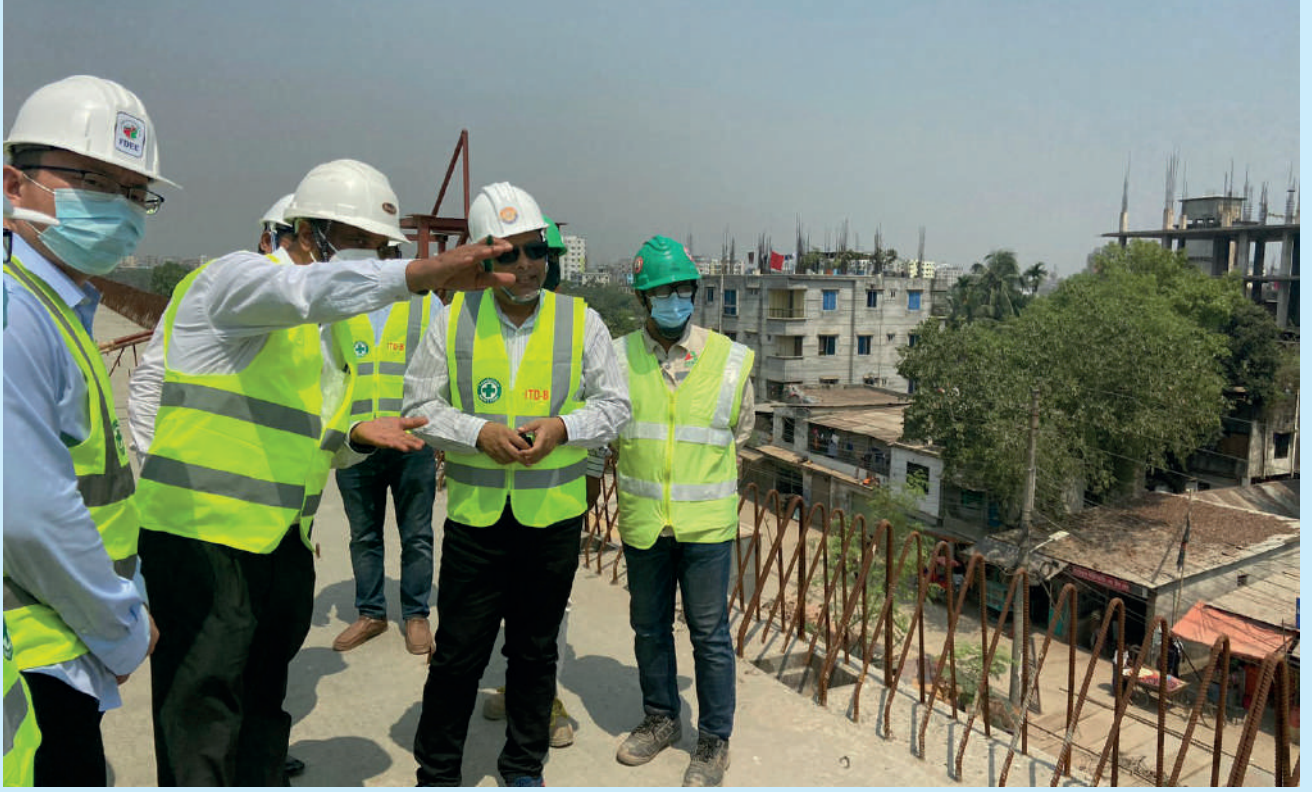
সেতু বিভাগের সচিব ও বাংলাদেশ সেতু কর্তৃপক্ষের নির্বাহী পরিচালক জনাব মো. মনজুর হোসেন-এঁর ঢাকা এলিভেটেড এক্সপ্রেসওয়ে নির্মাণ কার্যক্রম পরিদর্শন
