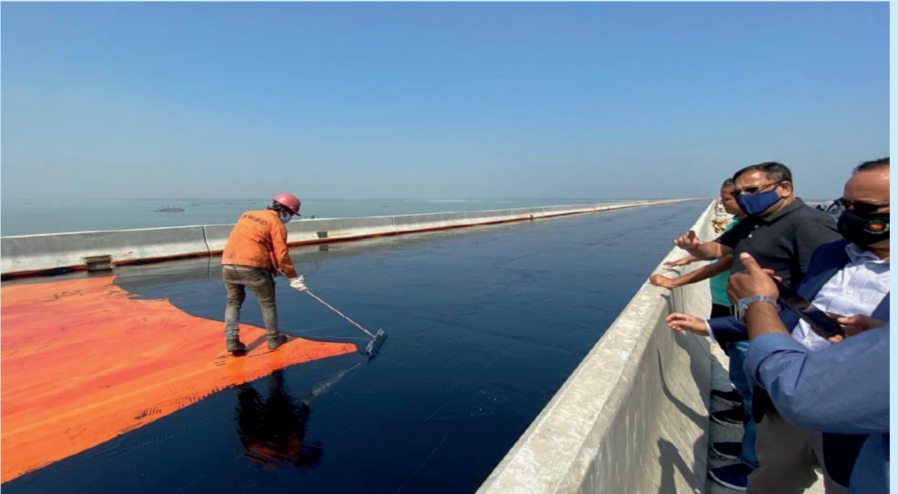
পদ্মা সেতুর নির্মাণ কাজ পরিদর্শনে সেতু বিভাগের সচিব ও বাংলাদেশ সেতু কর্তৃপক্ষের নির্বাহী পরিচালক জনাব মো. মনজুর হোসেন
