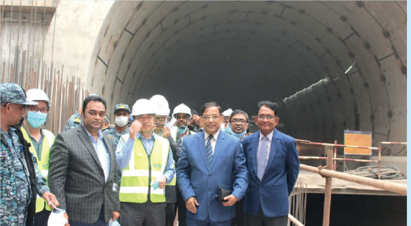
সেতু বিভাগের সচিব ও বাংলাদেশ সেতু কর্তৃপক্ষের নির্বাহী পরিচালক জনাব মো. মনজুর হোসেন-এঁর টানেলের নির্মাণ কাজ পরিদর্শন
